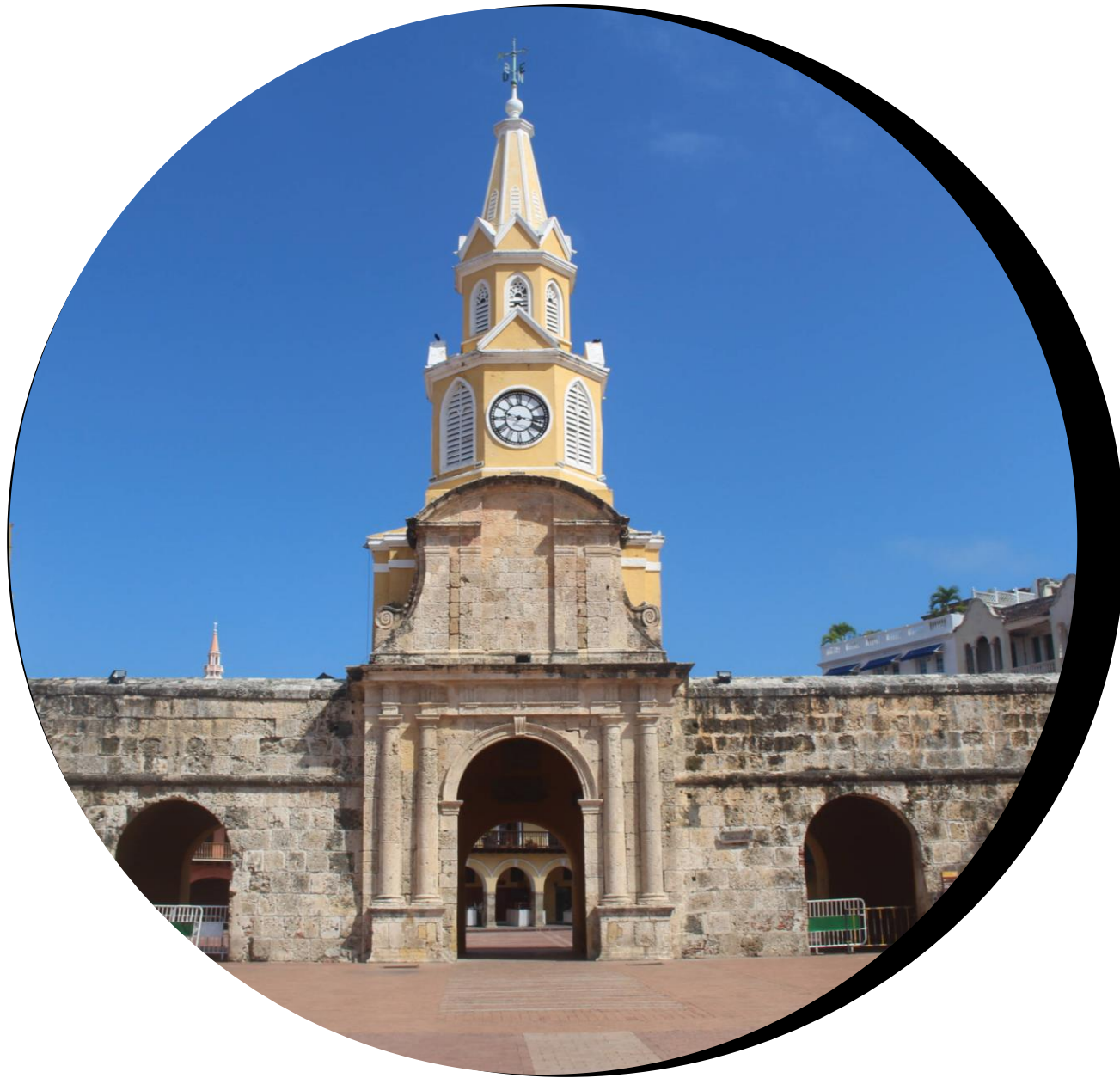
Obra civil torre del reloj de Cartagena, Colombia.
